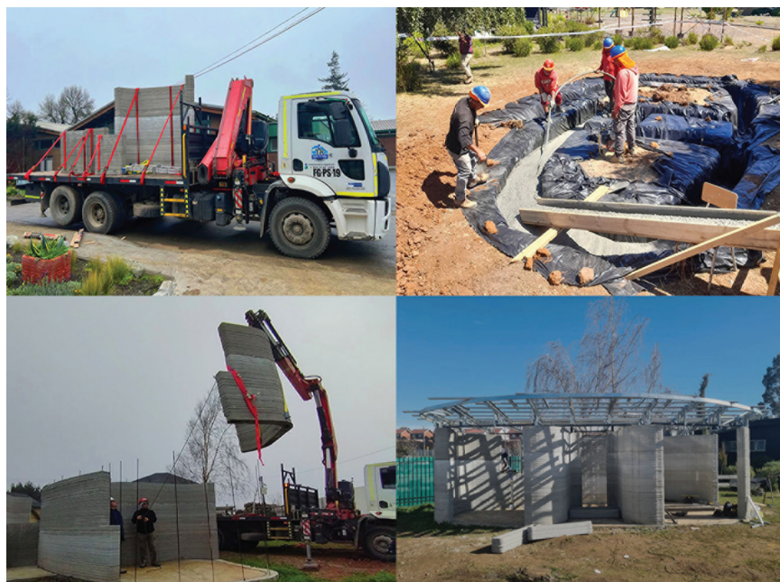
Slika 7. Montaža 3D tiskanih zidova na gradilištu (lijevo) te izvedba temelja i krovišta (desno)
