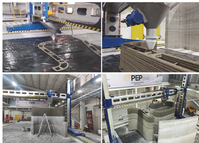
Slika 6. tisak zidova u sveučilišnome laboratoriju
