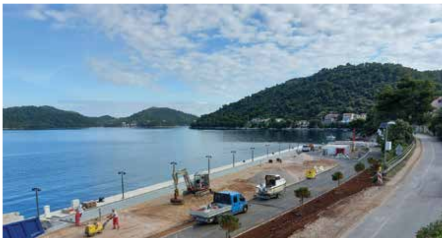
Završni radovi na gradilištu snimljeni u lipnju 2025.
