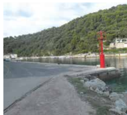
Postojeće stanje luke prije rekonstrukcije
