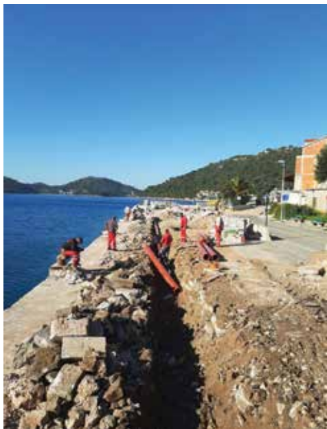
Radovi na polaganju cijevi oborinske odvodnje
