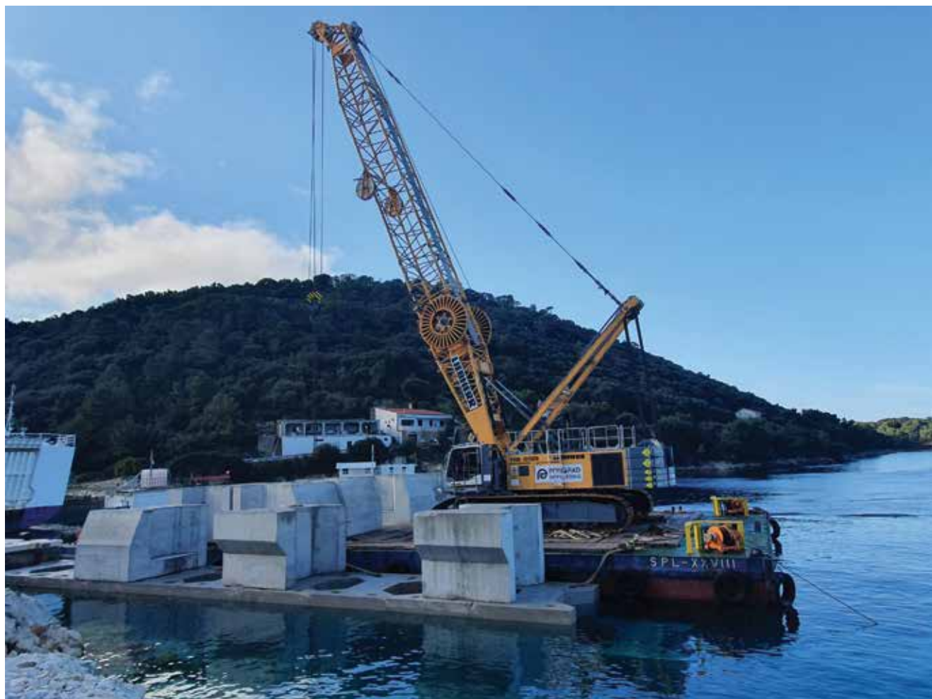
Detalji s gradilišta trajektnog pristaništa
