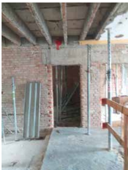
Radovi na obnovi zgrade u Schrottovoj ulici
