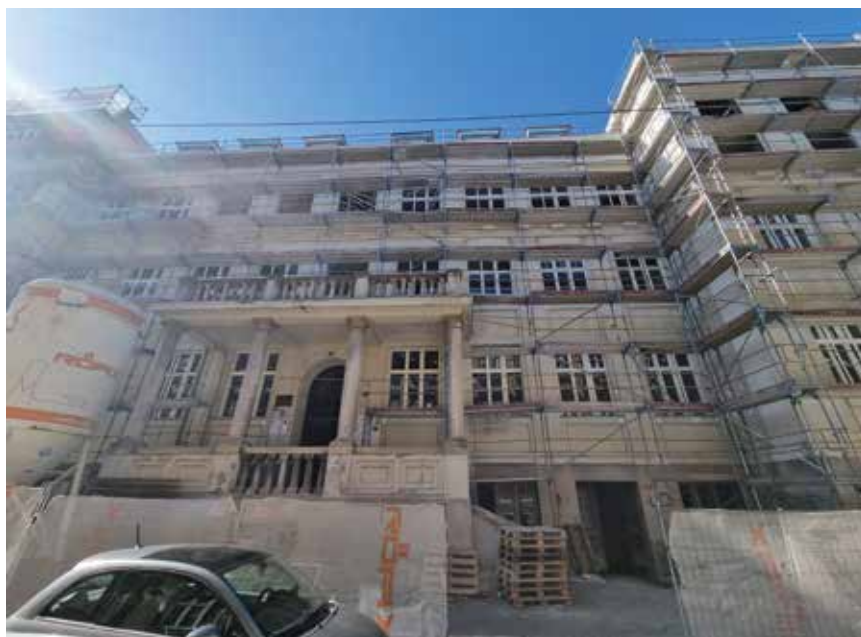
Radovi na vanjskim dijelovima zgrade
