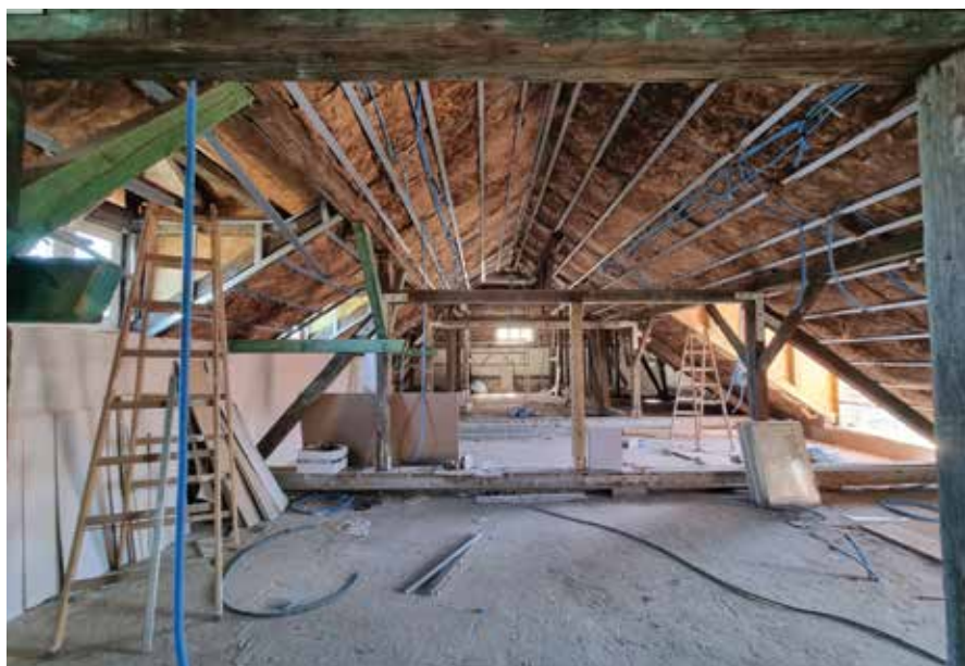
Radovi na krovnoj konstrukciji
