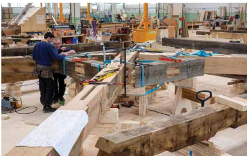
Izrada elemenata nove krovne konstrukcije u radionici (Foto: David Bordes/Institution to Rebuild Notre-Dame de Paris)
