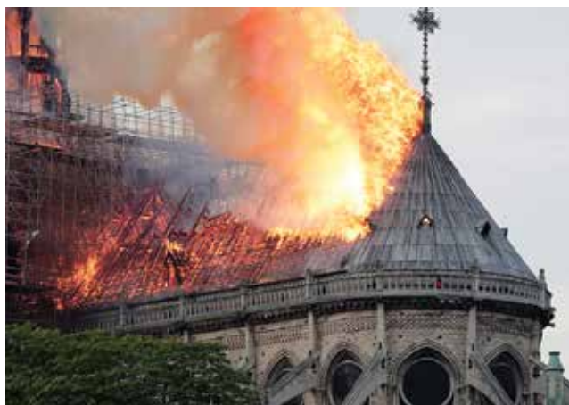
U požaru su izgorjeli krov i toranj na krovu
