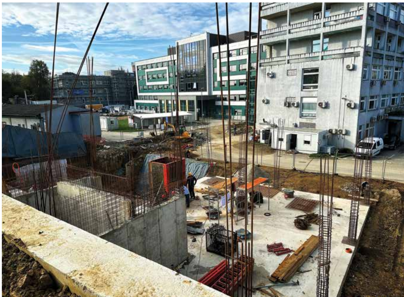
Detalj s gradilišta Opće bolnice "Dr. Ivo Pedišić"
