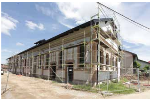
Centar za mlade tijekom gradnje i nakon završetka radova
