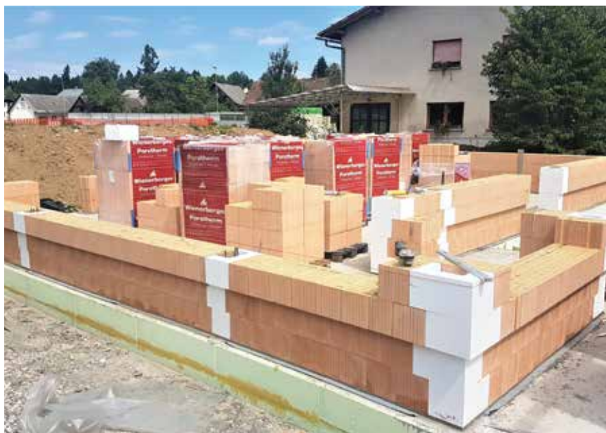
Detalj s gradilišta - gradnja sustavom Wienerberger
