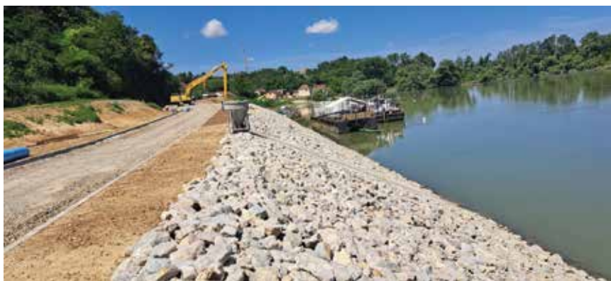
Detalji snimljeni tijekom gradnje zimovnika
