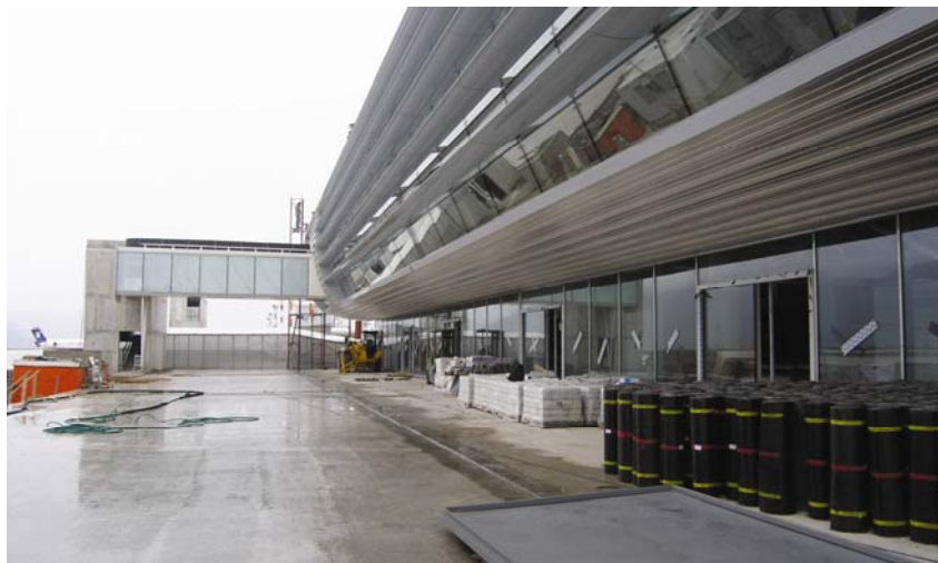
Radovi tijekom posjeta na sjevernoj strani zgrade B
