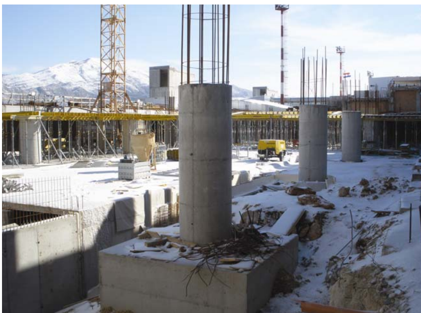
Radovi pod snijegom u veljači 2009.
