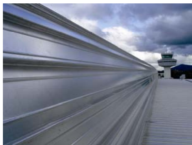
Detalj pokrova zgrade B
