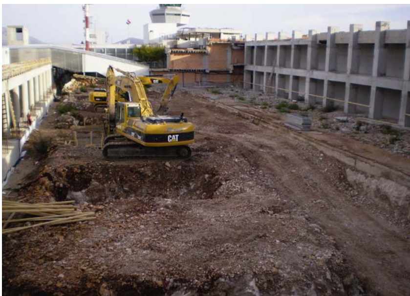
Zemljani radovi u početku građenja zgrade B
