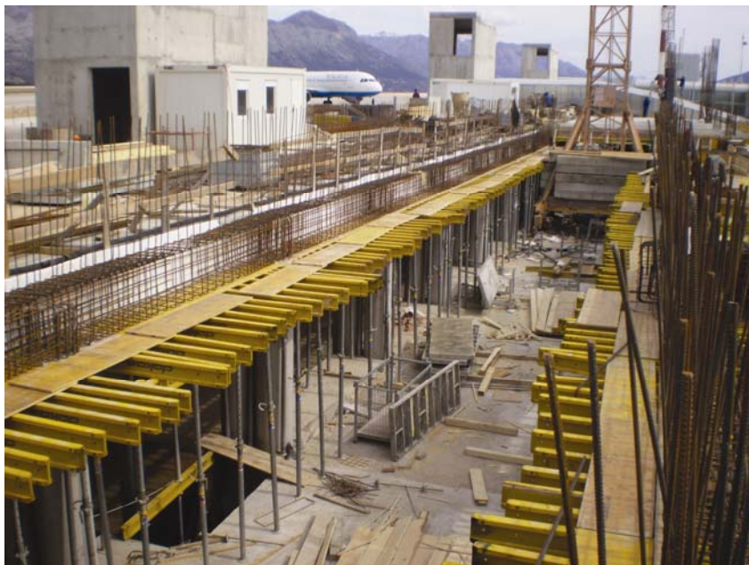
Armiranobetonski radovi na zgradi B
