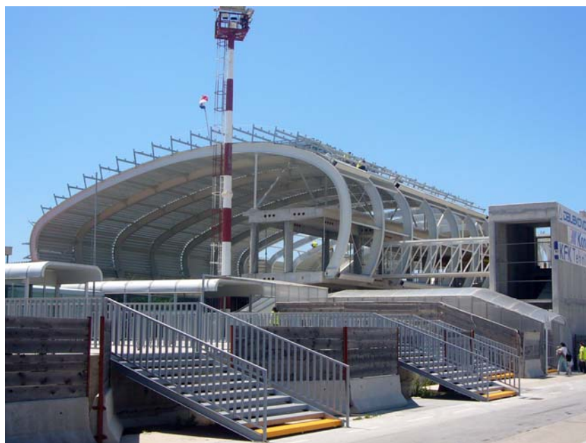
Montaža nosača čelične konstrukcije
