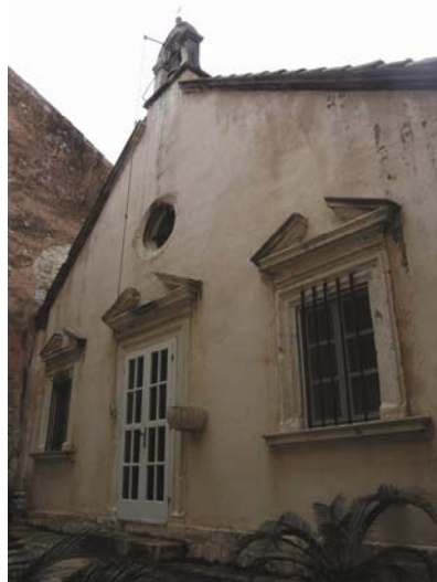
Dvorišno pročelje Sigurate
