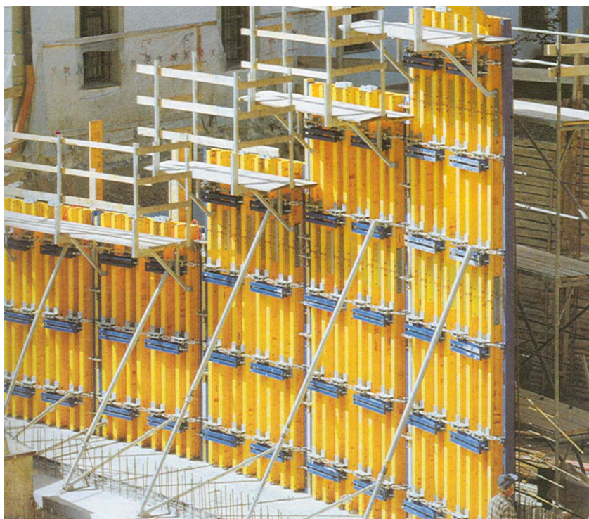
Oplata kružnih zidova H20
