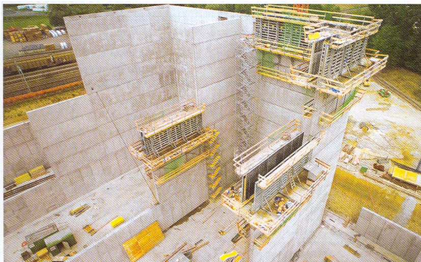
Okvirna oplata FramaxXlife za oplaćivanje velikih površina
